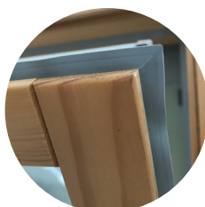
Guarnizione perimetrale del battente saldata agli angoli
